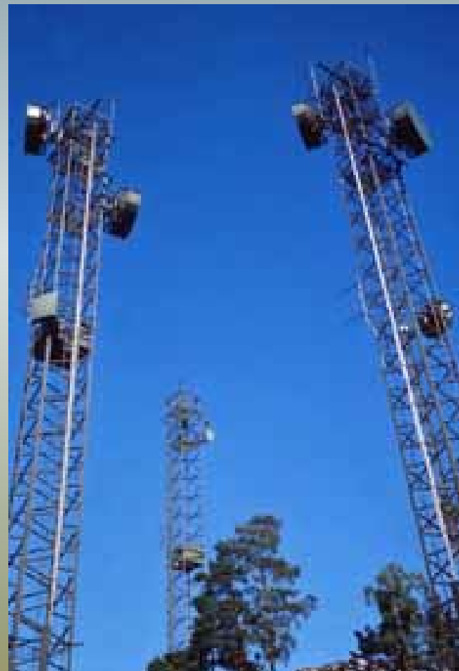
Antenntorn med olika typer av parabolantennor
