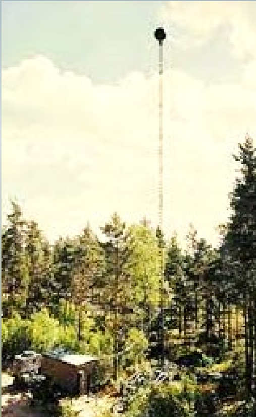
RL-47 med antenn i "kulradom"
