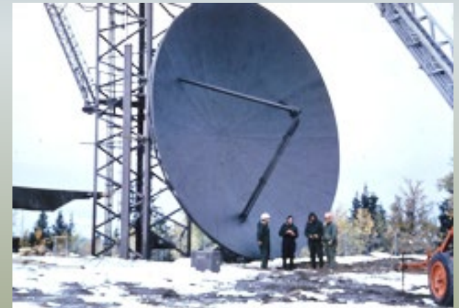
RL-71 antenn. Ingick i scatterstråket Östersund till övre Norrland. I drift 1962 - 1972
