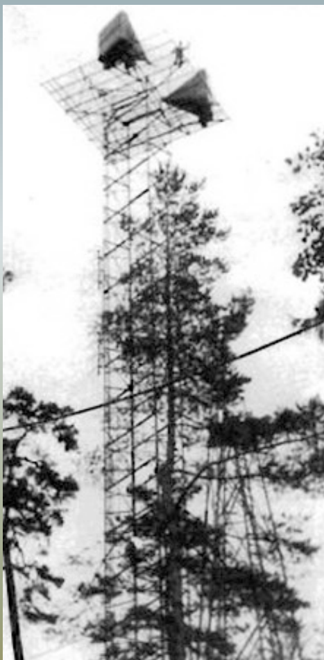
Antenntorn med två Siemens linsantennor
